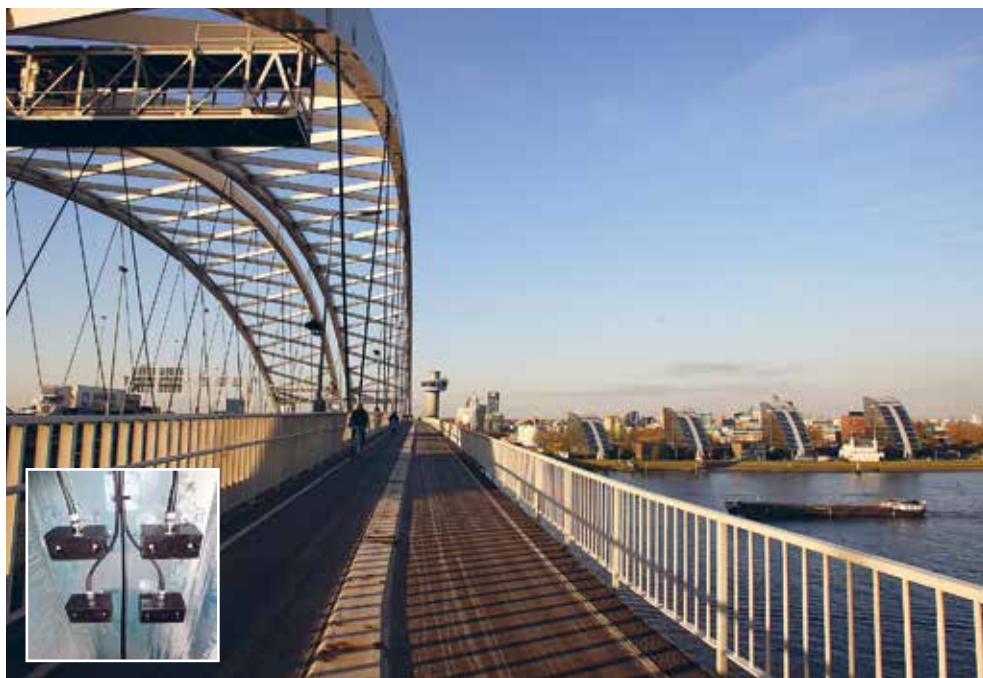
Op de Van Brienenoordbrug zijn AE-sensoren geïnstalleerd
