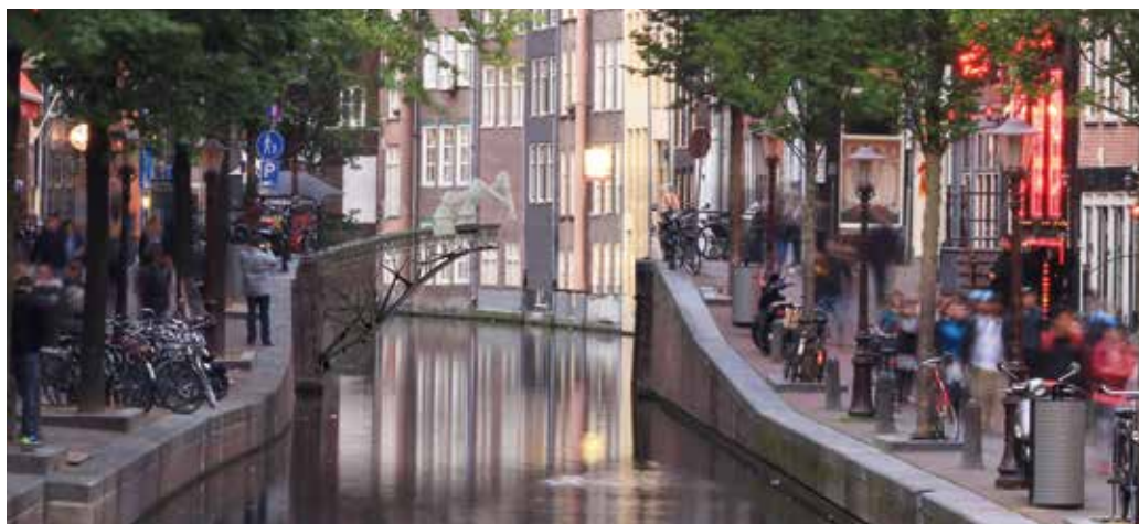
Een 3D-printer bouwt een brug over een gracht in Amsterdam
